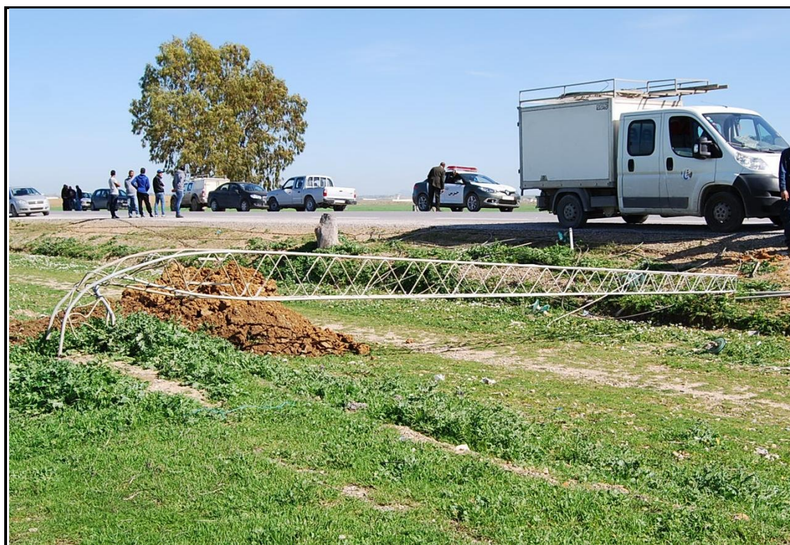
Poteau électrique déformé et tombé sur le sol
